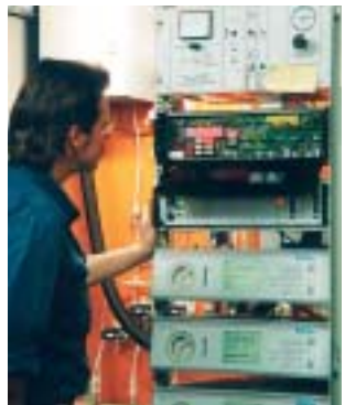
Schadstoffbestimmung in der Messstation am Kamin des Müllheizkraftwerks Kiel.
