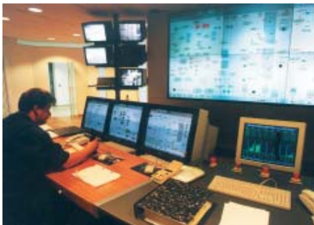
Die Leitwarte des MHKW: ganz rechts der Bildschirm des Emissionsauswertungssystems.
