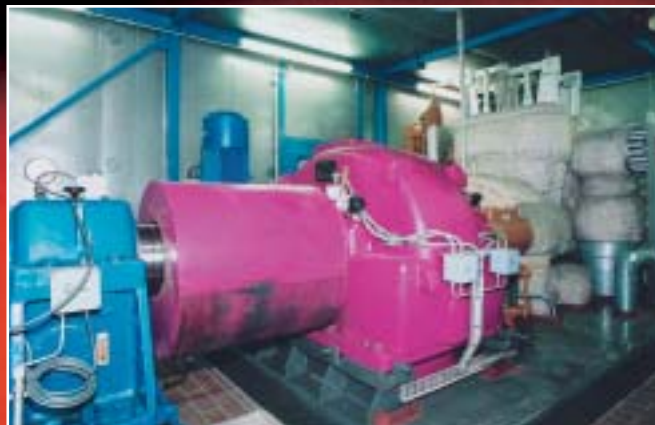
Turbosatz zur Stromerzeugung und Dampfentnahme
